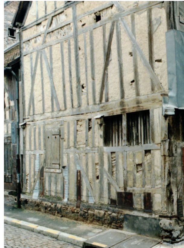
Façade de la rue de la Crosse avant travaux (1975). À l'exception du rez-de-chaussée notamment sa sablière et son soubassement le pan de bois d'origine a pu être conservé.
