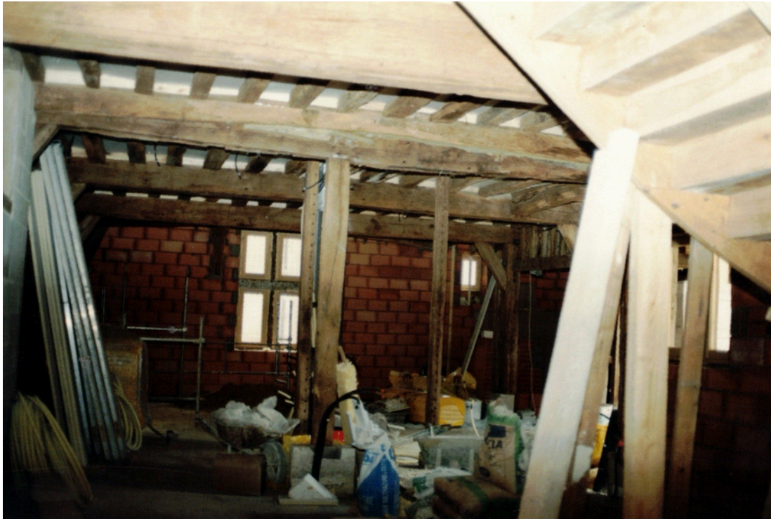
Chambre La Chapelle pendant les travaux (1994)
