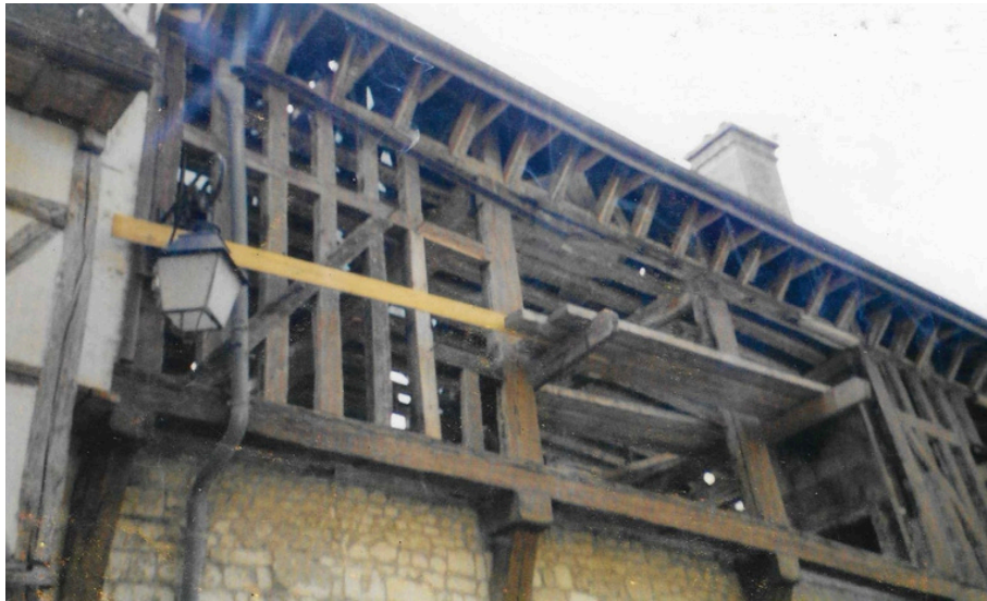
Pendant les travaux , octobre 2001 façade Nord, Rue Linard Gonthier
